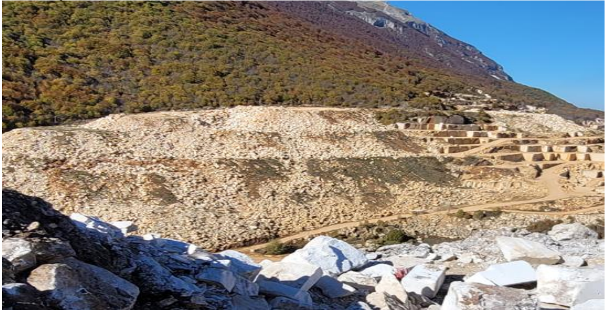
Pamje nga një rehabilitim pjesor Bashkia Çorovodë (Grupi i auditimit, 2024)
