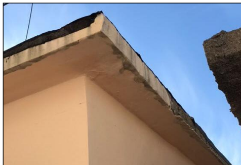
Punimet e h/izolimit të realizuara në banesën e F. Ç. të cilat nuk mbulojnë të gjithë konturin e soletës
