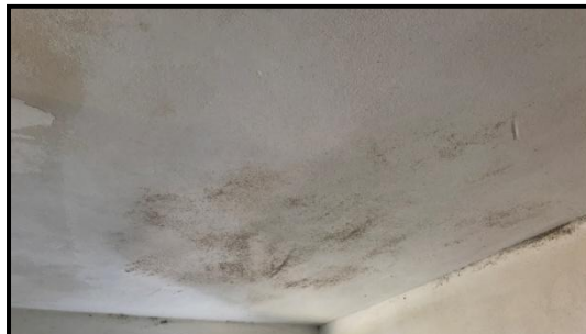
Punime jo cilësore të h/izolimit të soletës të cilat kanë sjellë praninë e lagështisë në banesën e M. D.
