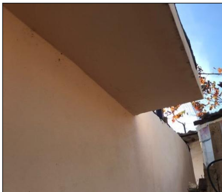
Punimet e h/izolimit të realizuara në banesën e P.N. të cilat nuk mbulojnë të gjithë konturin e soletës
