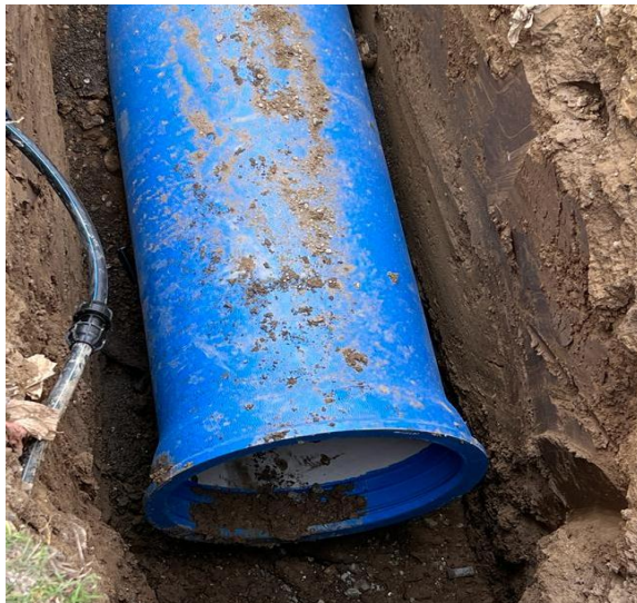
Fig. 1 Mungesa e rërë poshtë kuotës së poshtme të tubit
