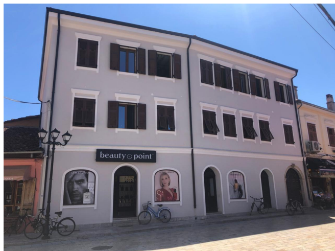
Figura nr. 12 Objekti pas përfundimit të punimeve Burimi Grupi i Auditimit
