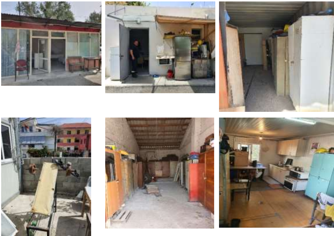
Stacioni zjarrfikës tuneli Krrabë
