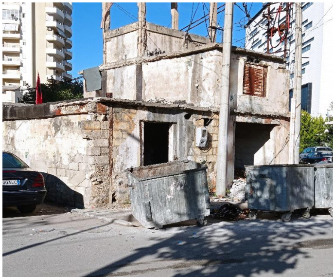
Rruga Aristill Kokoshi – kontenierë të dëmtuar; zona e pa dezinfektuar
