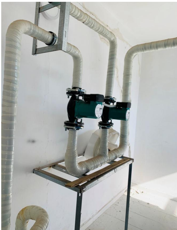
Foto 2. Pompat e kaldajës në sasinë 2 copë dhe fuqia e kaldajës prej 180,000 kcal/h (209.2)
