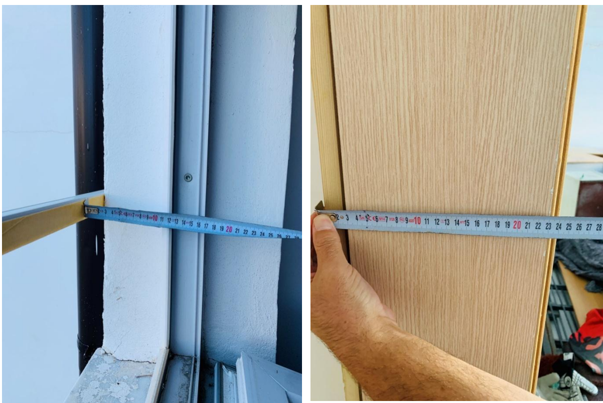
Foto 1. Trashësia e murit të jashtëm ku është e përfshirë dhe 5cm veshje me polisterol dhe 2 cm suvatim dhe trashësia e murit të brendshëm ku zbritet kasa e detyrë 2 cm dhe suvatimi 2cm.
